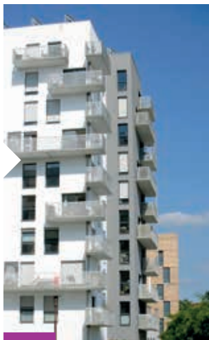
Logement - Île de Nantes.
