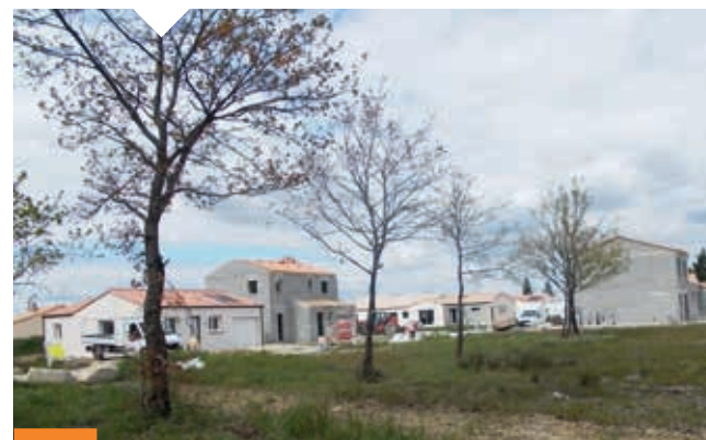
Construction de logements - Saint-Jean-de-Boiseau.
