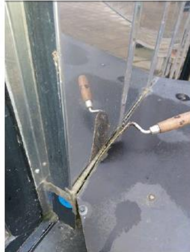
JOINT DE COUVERTINE A REPENDRE
