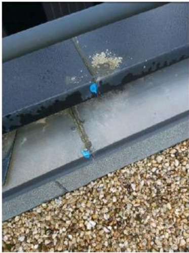
JOINT DE COUVERTINE A REPENDRE
