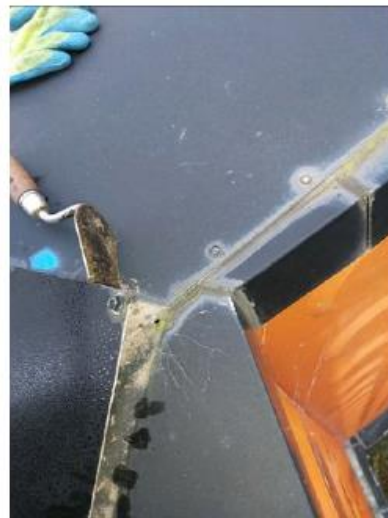
JOINT DE COUVERTINE A REPENDRE
