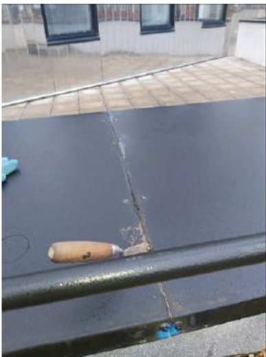
JOINT DE COUVERTINE A REPENDRE
