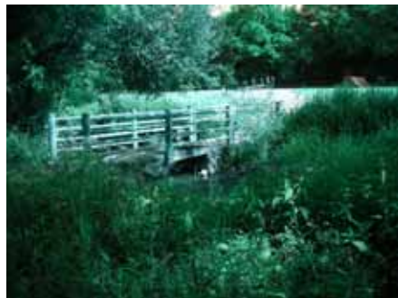
Photo 3 - Exemple de franchissement terrestre : les passerelles.
