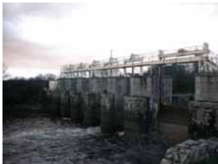
Photo 5 - Écluse du canal de Buzay (vue aval).
