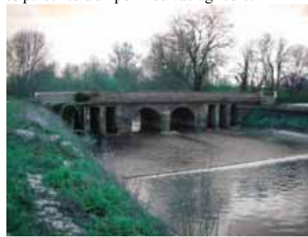
Photo 6 - Ouvrage d'art à l'amont immédiat du canal de Mâchecoul et de la station de pompage des eaux du Tenu.
