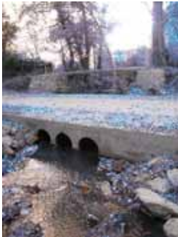
Photo 1 - Exemple de franchissement terrestre : les passages busés.
