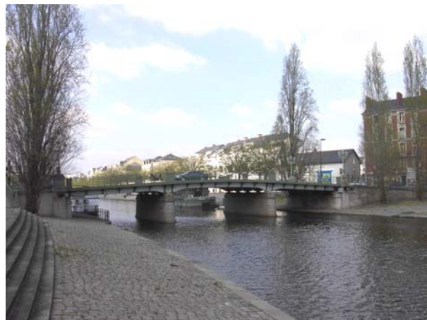
L'Erdre dans la traversée de Nantes
