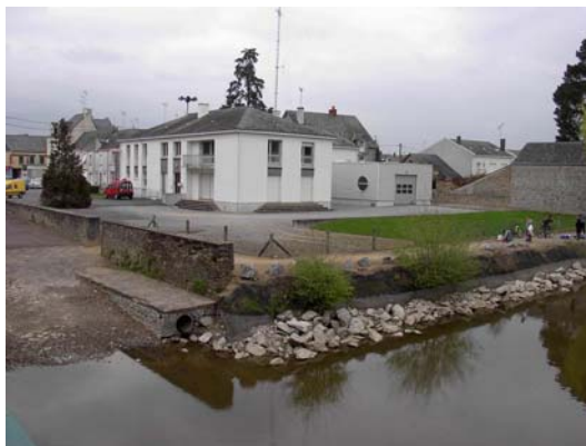
Caserne des pompiers à St-Mars-la-Jaille
