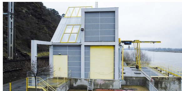
Station de pompage de Mauves sur Loire
