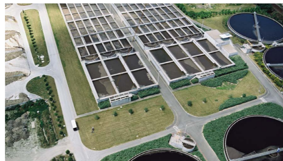
Station d'épuration de Tougas
