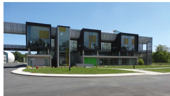
Station d'épuration Petite-Californie
