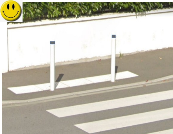
Rue de la Cadoire, Rezé Niveau du trottoir descendu – Nécessite l'autorisation du riverain et de refaire le crépi. Une autre solution peut être un chanfrein sur 20 cm de large environ ou un coffrage pour cacher les fondations.
